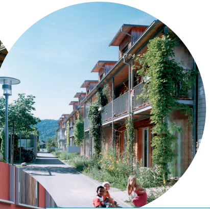
Attraktive Erschließungsräume zum Dorfplatz hin orientiert
